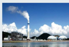
工业废水处理
